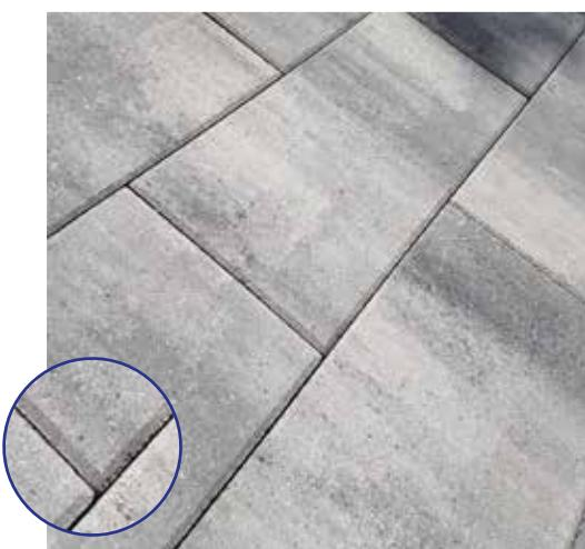
Поверхность из тротуарной плитки с большой (стандартной) фаской отличается повышенной стойкостью даже в случае интенсивного использования
